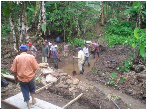
Erste Arbeiten an der Quellenfassung
