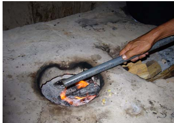
Reparatur von Wasserleitungen
