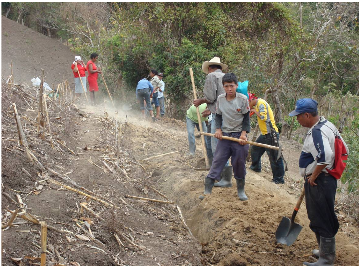
Zuschütten der Gräben in Yalí
