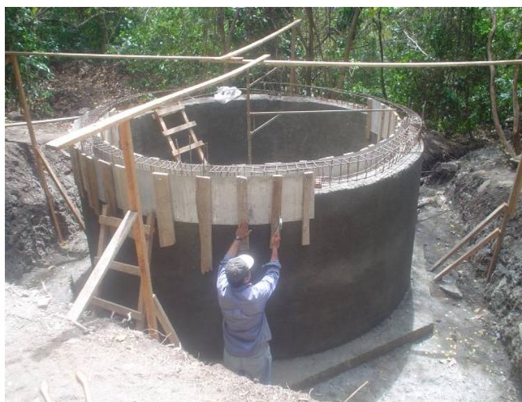
Reservoirkonstruktion in Yalí
