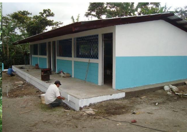
Die letzten Arbeiten am neuen Schulhaus
