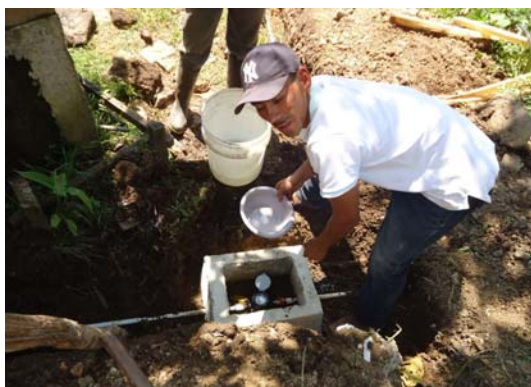
Einbau von Wasseruhren in El Sardinal
