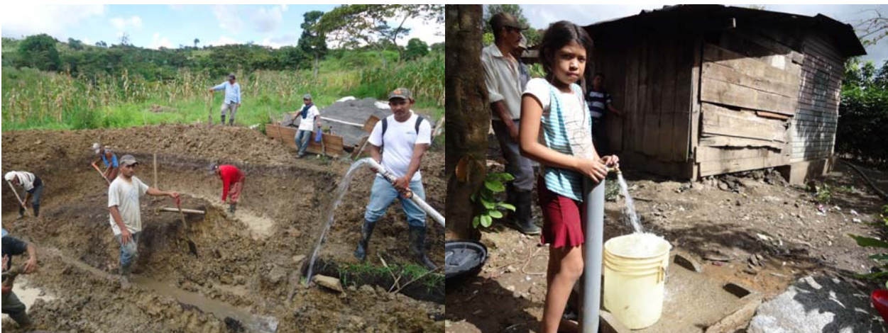
Links: die Quelle ist erfasst, der Bau des Reservoirs beginnt. Rechts: erste Häuser haben Wasser
