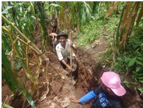
Leitungsbau in El Tuma
