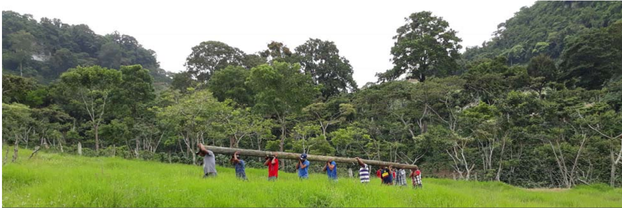
Transport des Strommastes
