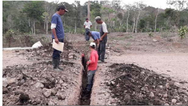
Verlegen der Wasserleitungen
