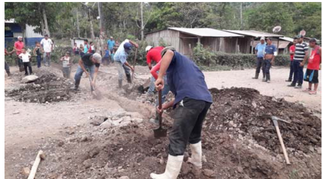
Arbeiten in Santa Amalia
