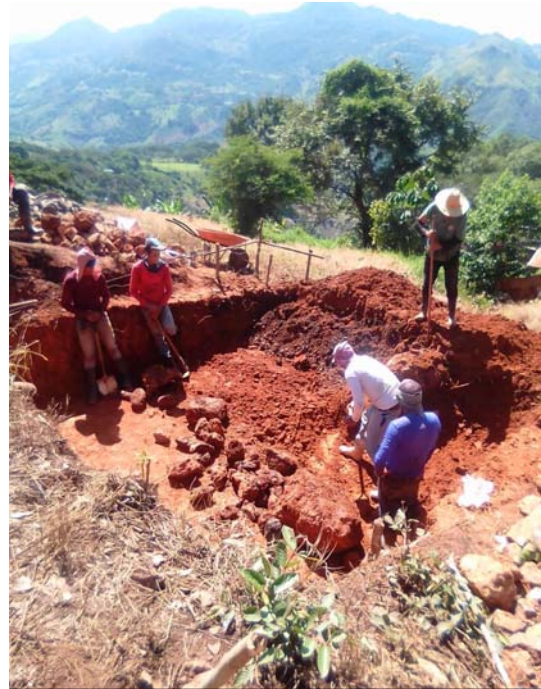
Vorbereitung für den Bau des Reservoirs
