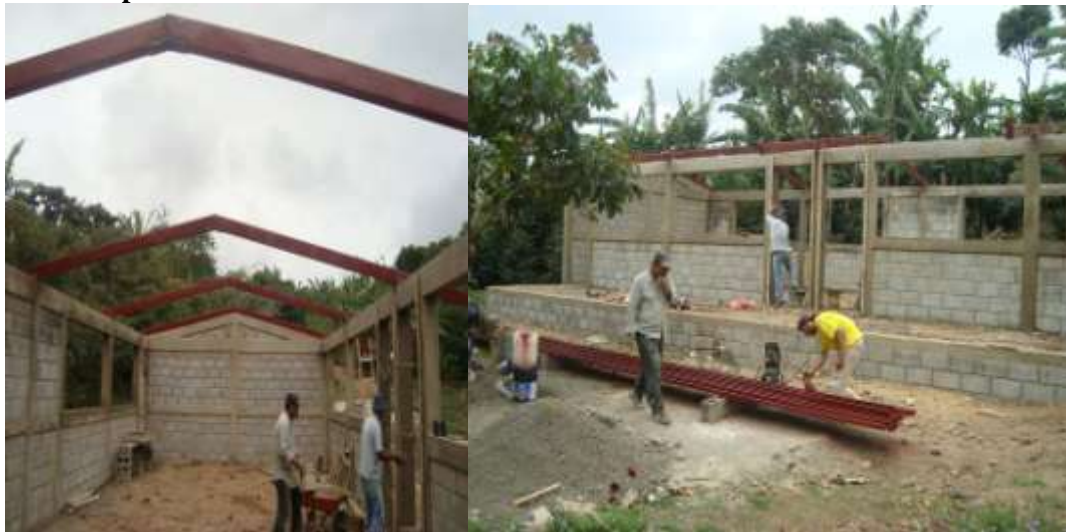
PERSONAL DE PROFINIC CONSTRUYENDO LA NUEVA ESCUELA.
