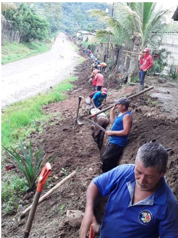
Bilder: Arbeiten in El Destino
